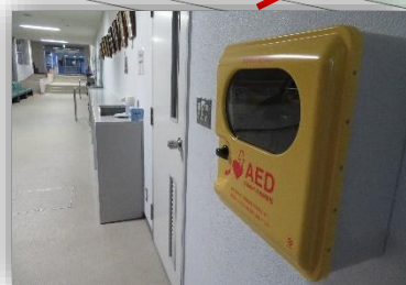
●講堂棟（南側入り口付近）
