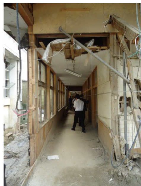
⑥体育館裏校舎の廊下の様子
