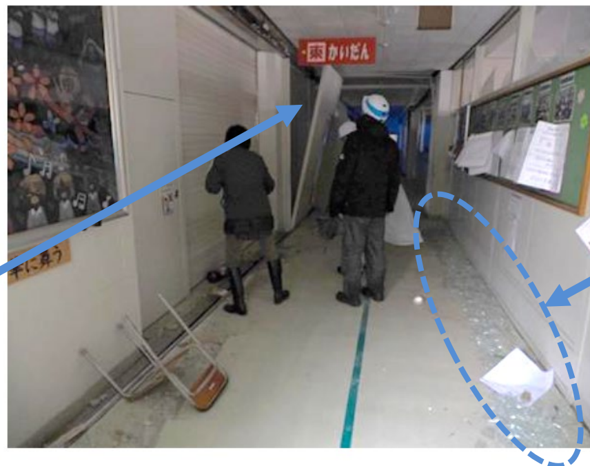
写真 5. 4. 2-37 建物内部のガラスの散乱状況
