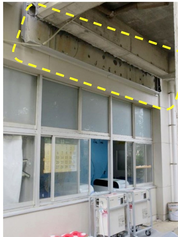
写真 5.3.2-25 建築物 B-4 と別棟の間の Exp. J. のずれ
