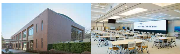
第二研修棟 第二研修棟 内部
