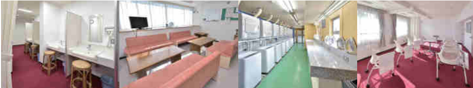
第一宿泊棟 シャワー室
